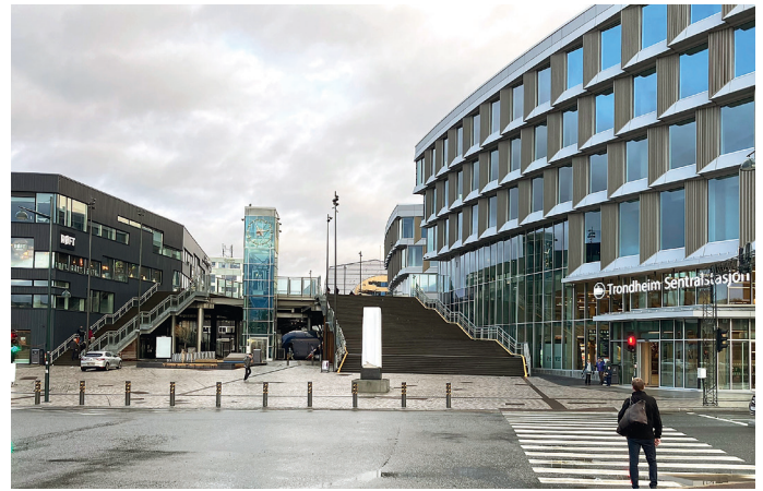
Stasjonen ligger inn mot Sjøgangen – gangbrua som fører over til hurtigbåtterminalen.
